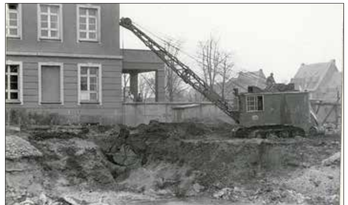
Tiefbauarbeiten für den Ostflügel; 1958 Foto: LA Merseburg; I 525; Leuna-Werke Lichtbildsammlung
