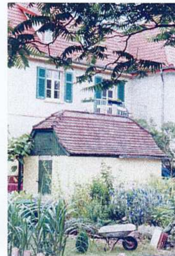
Nebengebäude mit gestalterisch gelungener Sanierung.
