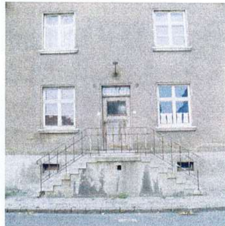
Blockstufen mit kleinem Überstand und geputzter Wange.
