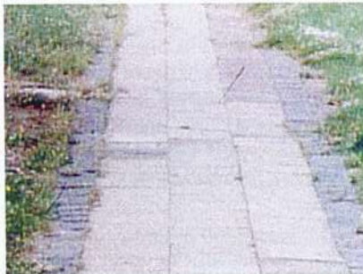
Betonplatten mit Einfassung
