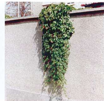
Verputzes Mauerwerk mit Begrünung
