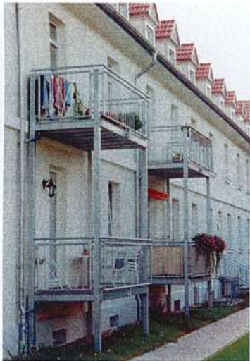
Vorgestellte filigrane Balkonkonstruktion in Stahl ausgeführt.
