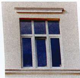
Waagerechte Verdachung, Brüstungsgesims
