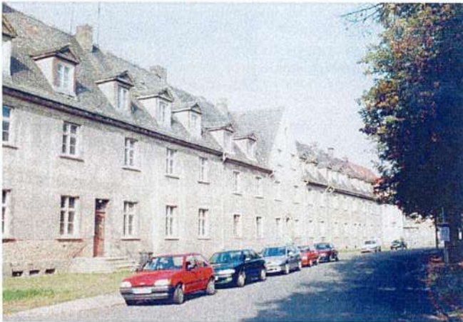
Lange Gebäudefluchten werden durch Zwerchgiebel gegliedert.
