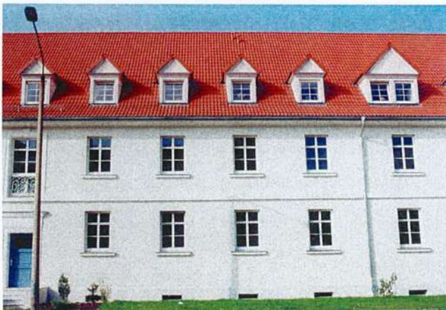
Gauben nehmen den Bezug zu den darunterstehenden Fensterfluchten auf.
